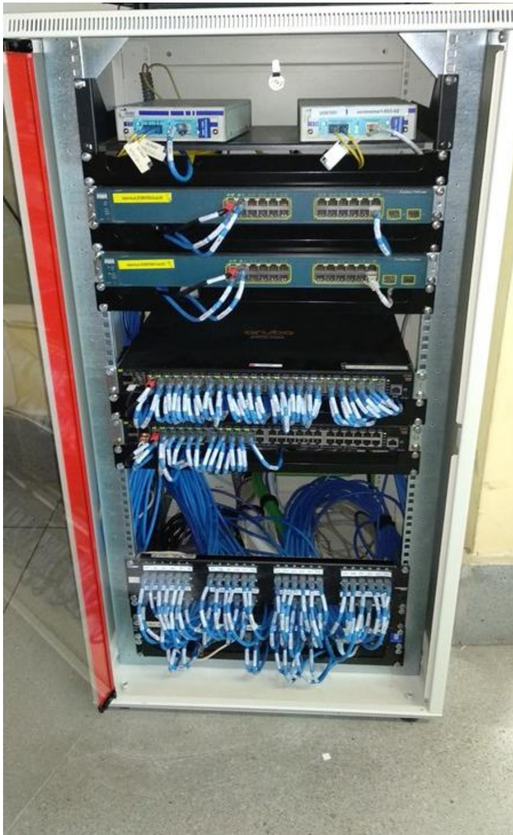
Figura 17 - Armarios de 24 U de dos puertas
