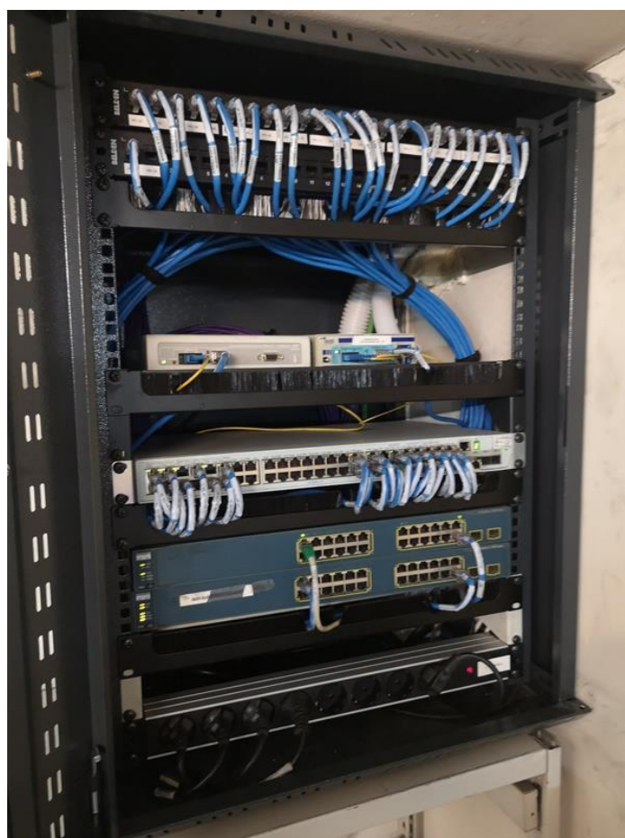
Figura 18 - Armario de 15 U y de 9U de una puerta
